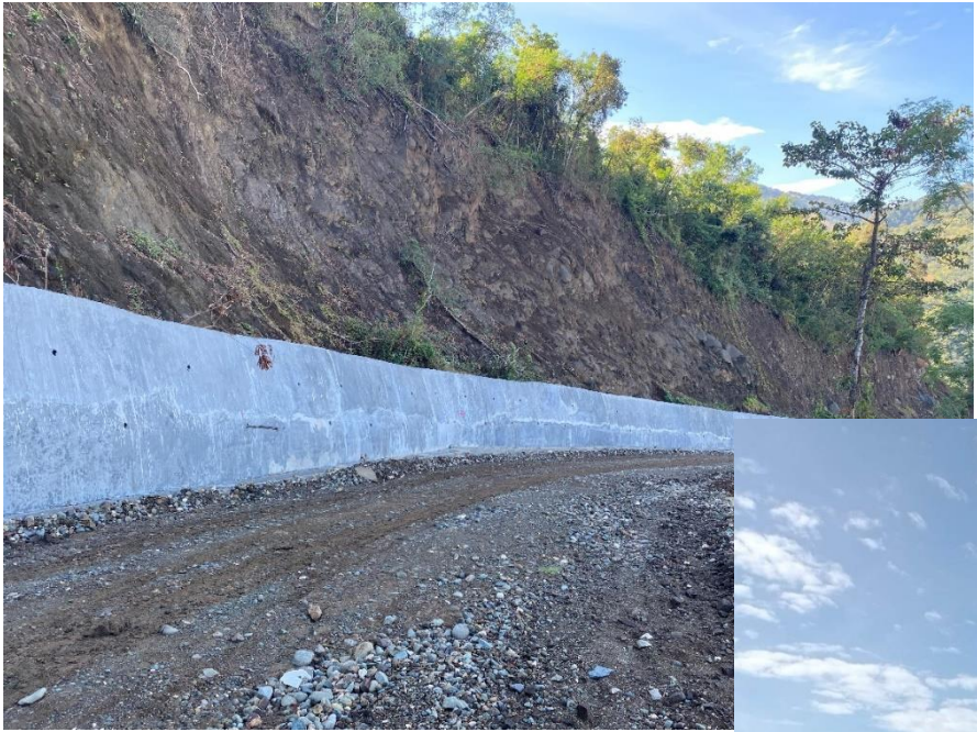
Nueva Era Access Road
