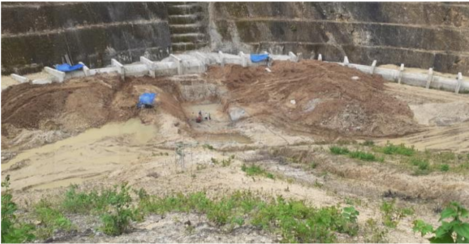
Diversion Conduit, CALUNASAN SRIP
