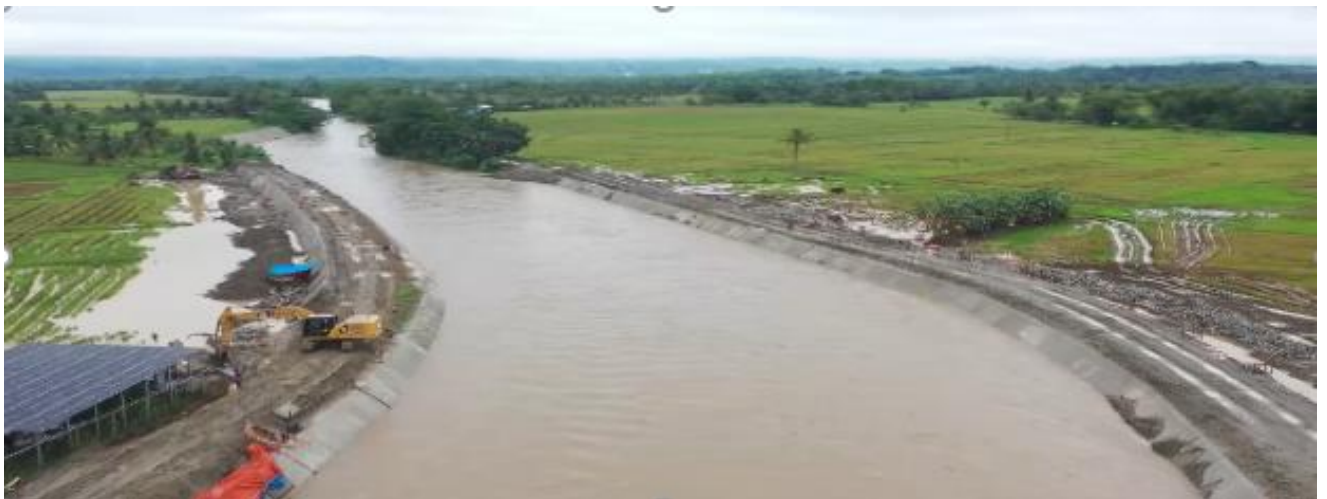
142m Protection Dike
