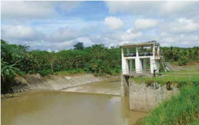
Baobo River Irrigation System Veruela, Agusan del Sur
