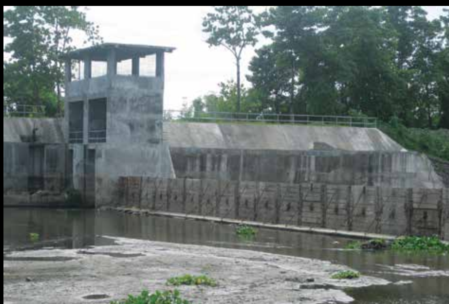
Sto. Cristo Dam Sto. Cristo Lubao, Pampanga
